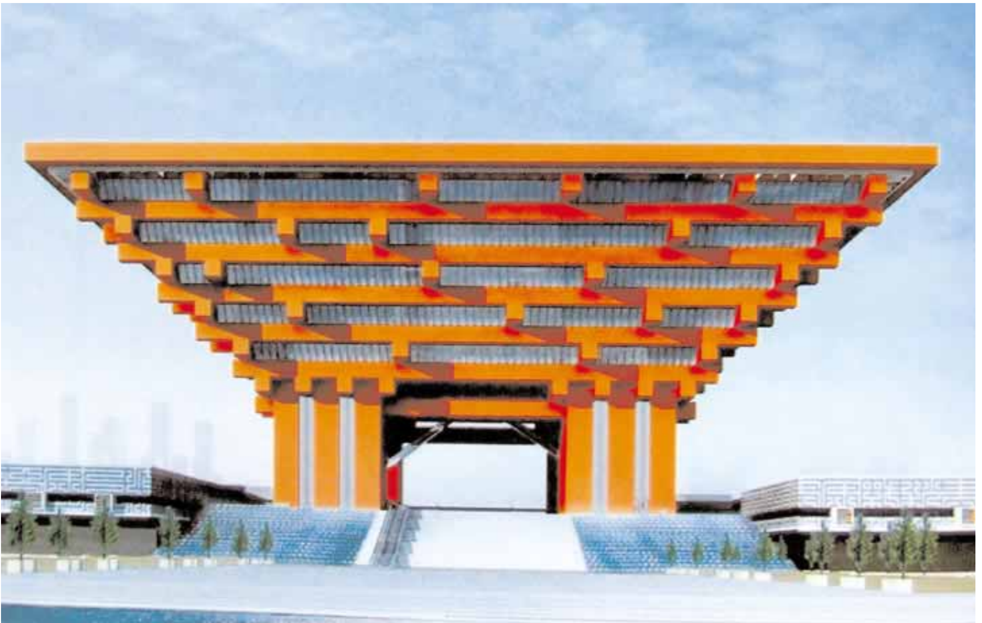
Vista frontale del Padiglione della Cina
